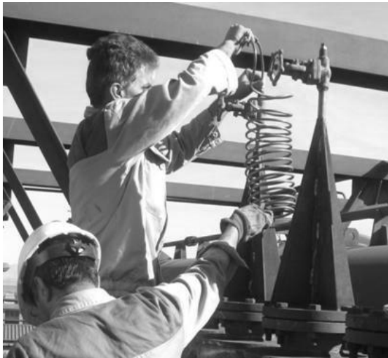
شکل ۵- نمایی از تجهیزات طراحی شده جهت کنترل عملکرد کاتالیست [3]
